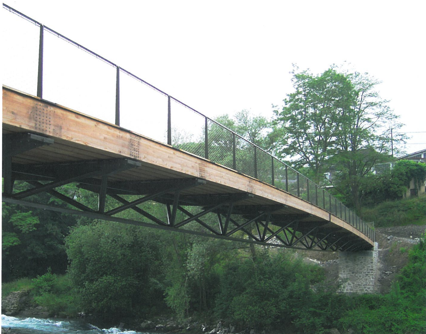
Passerelle à Oloron-Sainte-Marie.
