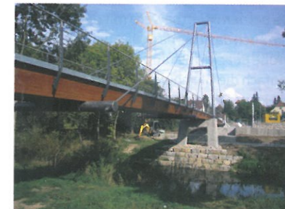
6 Pylon und Traversen aus Stahl © Ingenieurbüro Miebach
